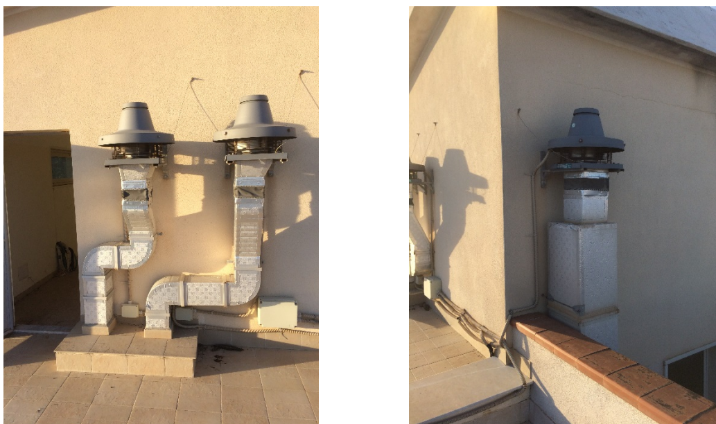
Figura 8 – Estrattori in testa ai camini di ricambio aria
