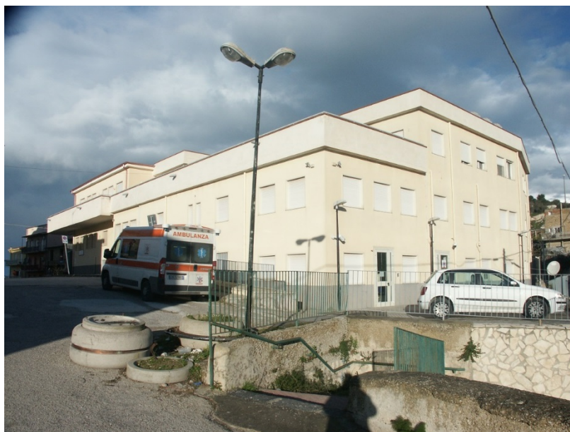
Figura 3 – Prospetti Sud – Est, con ingresso alla zona 118 a piano terra
